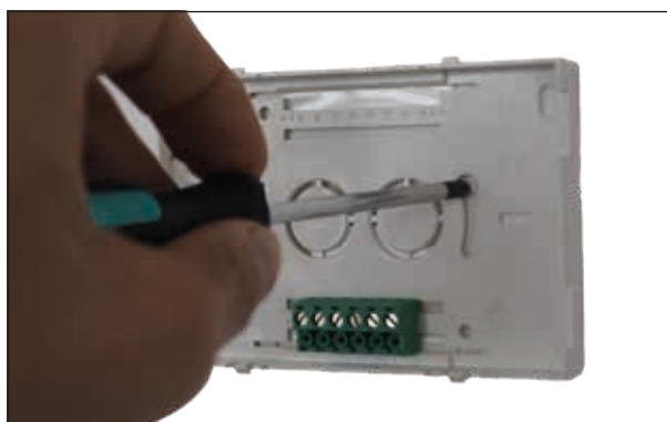
Przykręcenie płyty montażowej bramy
