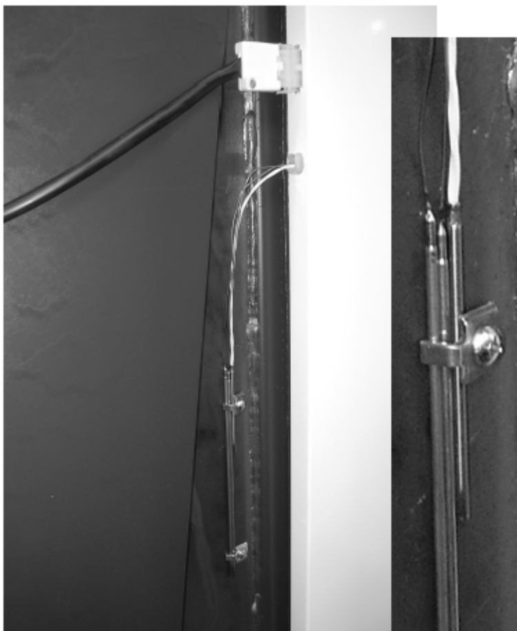
Pośredni czujnik AGF (DCxxGSE, DCxxGSX, DCxxRS) Musi być zakryty izolacją !!
