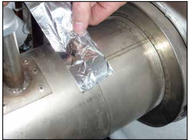
Abdichtung des Rauchabzugs mit Aluband
