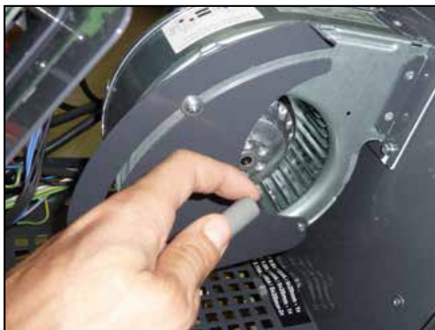
Ukázka čištění (vyfoukání) oběžného kola tlačného ventilátoru hořáku jednou za sezonu.
