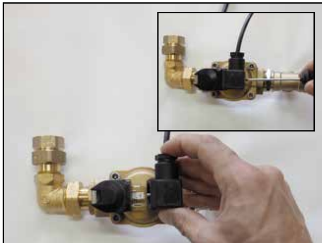
Zapojíme propojovací kabel na hlavu ventilu
