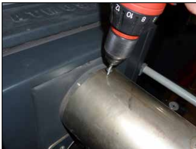
Ukázka zajištění kouřovodu šroubem
