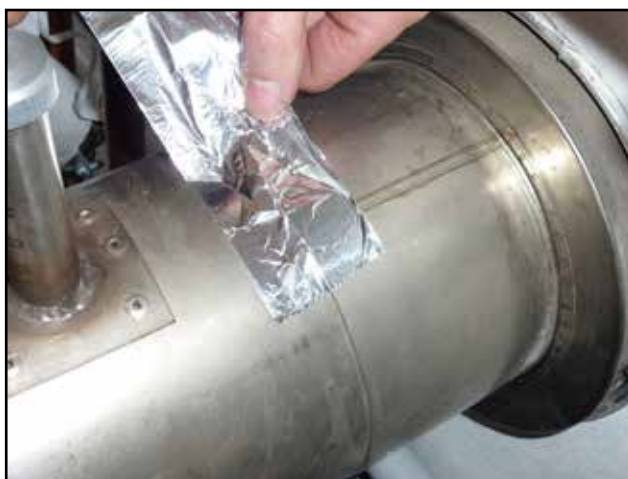
Utěsnění kouřovodu hliníkovou páskou
