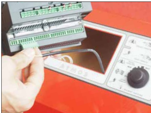
Przykład podłączenia poszczególnych złącz
