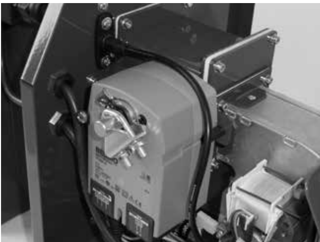
Abb. 11 - Sonderklappe mit Stellantrieb
