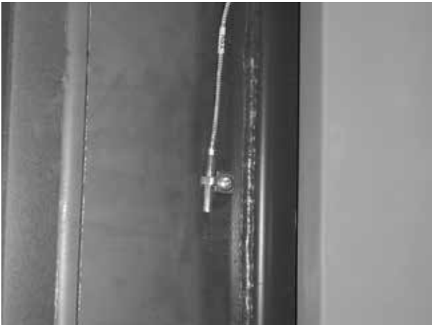
Abb. 15 - Ansicht des Abgastemperaturfühlers TSV an der Seite des Rauchkanals des Kessels DC40SPT, DC40GSP
