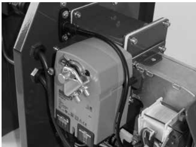
Obr. 11 - speciální klapka se servopohonem
