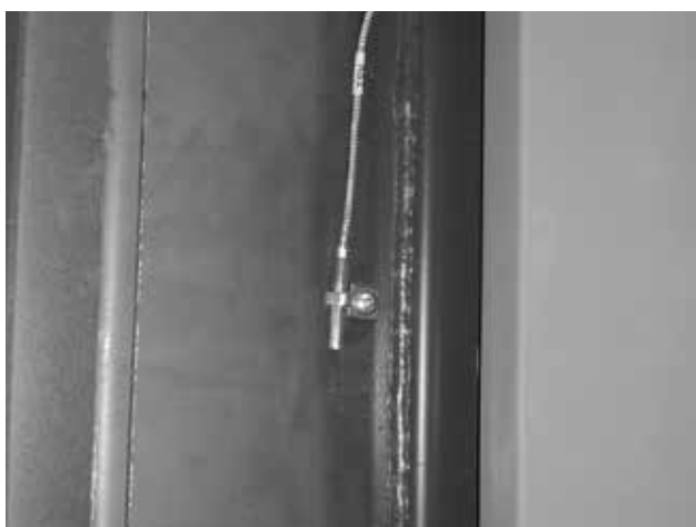
Obr. 15 - pohled na čidlo teploty spalin TSV na boku kouřového kanálu kotle DC40SPT, DC40GSP
