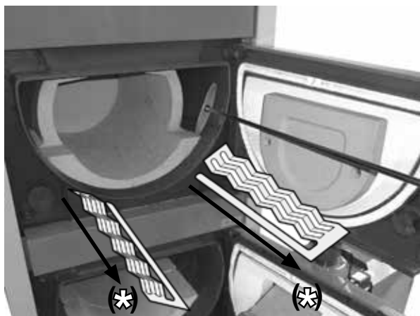
Offene mittlere Kesseltür mit dem Muster, wie die Asche durch das Schüreisen gereinigt ist *Nur bei DC18GSP, DC30GSP, DC40GSP
