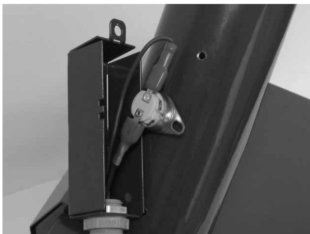
Rys. 10 - Termostat bezpieczeństwa przy zasypie komory spalania, 95 °C
