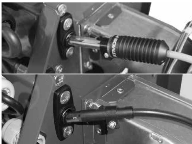
Obr. 4 - fotocela - pozor na správnou orientaci - doporučujeme minimálně jednou ročně očistit nová fotocela / stará fotocela
