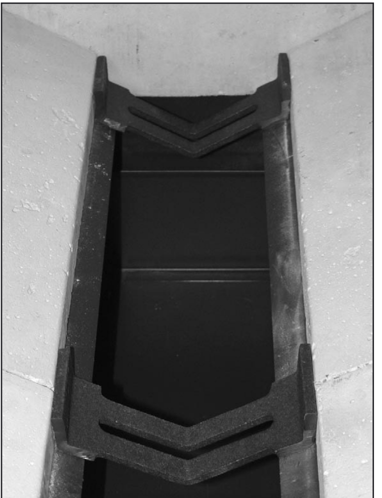
Usazení samotných rozpěrek v kotli D45P při instalaci hořáku A70 Petro.
