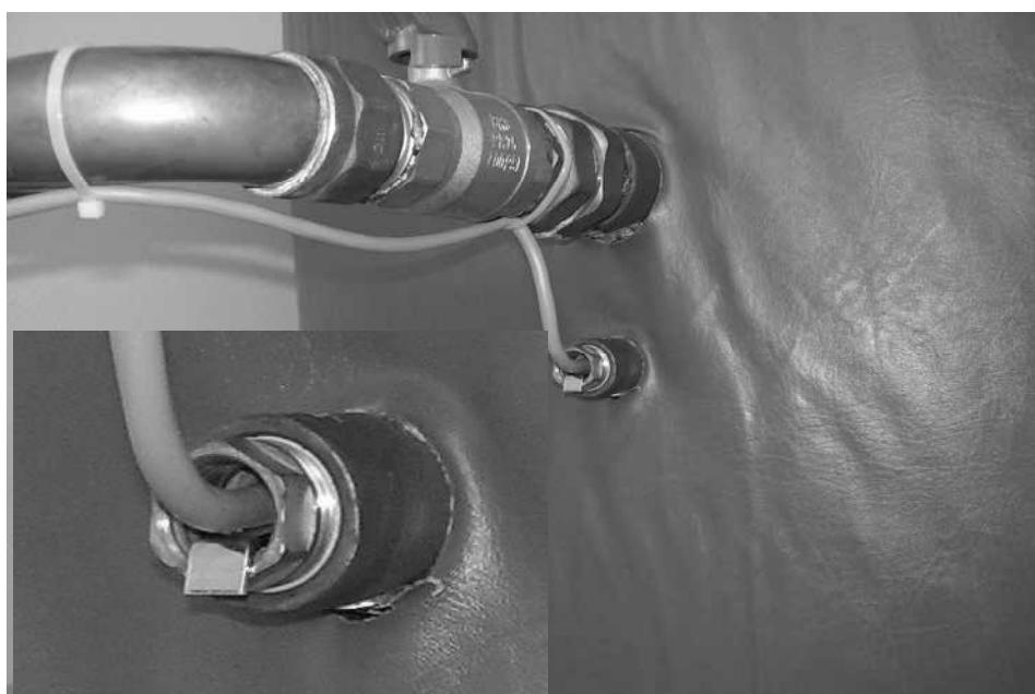
Čidlo teploty horní části nádrže PF (VEx), nebo čidlo TUV v kombinovaném ohřívači TUV zasunuté v jímce.
