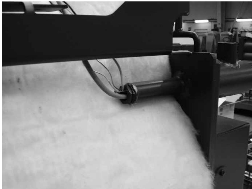
Čidlo kotlové teploty WF v jímce, přidané k ostatním čidlům termostatů původní elektromechanické regulace kotle.
