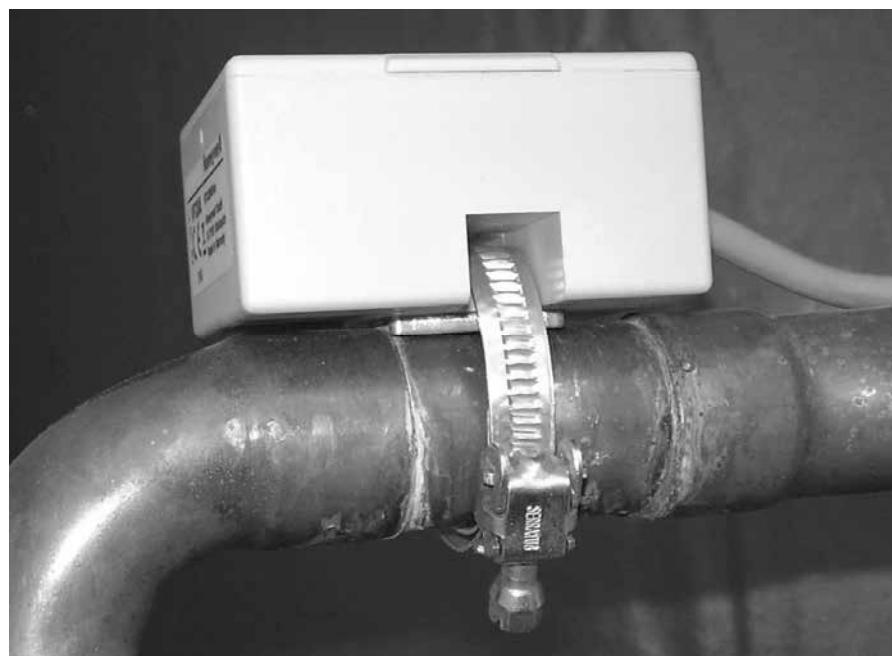
Příložné čidlo za mísícím ventilem do otopného okruhu.
