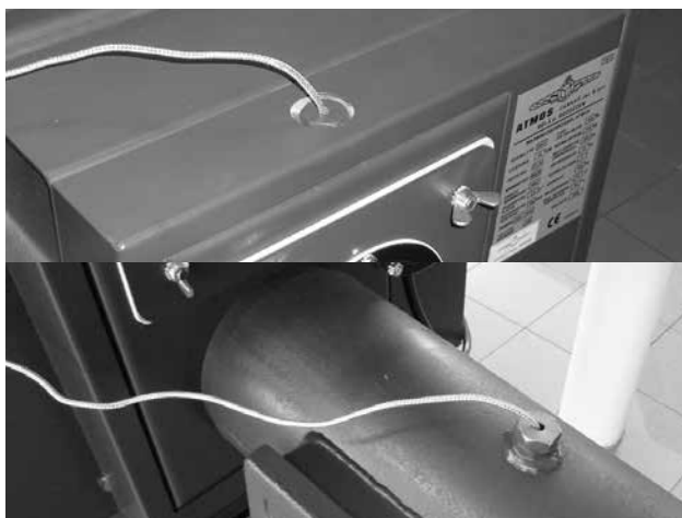
Rys. 14 – Widok czujnika temperatury spalin TS lub TSV podłączonego do łącznika kominowego. Przypadku kotłów D30P, D31P, D40P i D50P znajduje się na kanale dymowym kotła.
