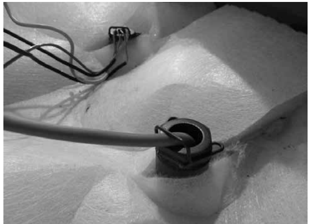
Abb. 16 - Ansicht des Wassertemperaturfühlers TK im Schutzrohr des Kessels DxxP
