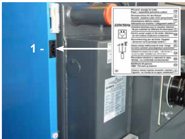
Conectori în partea dreaptă a cazanului
