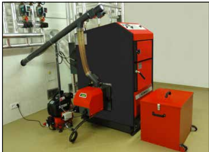
Příklad kotelny s kotlem D50P
