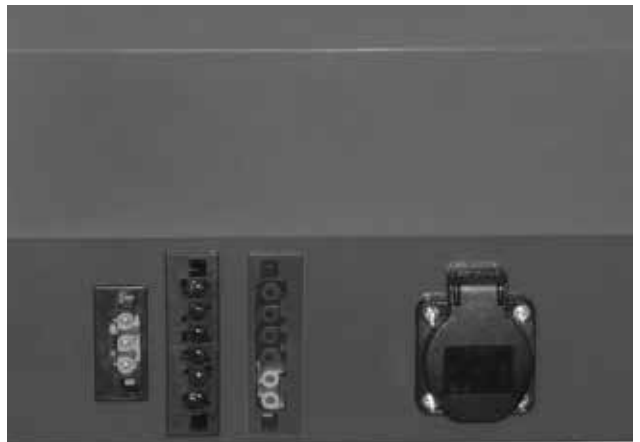
Abb. 12 - Brenner / zwei 6 Pin-konnetore,-links Spannung, rechts Fühler, 3-PIN-Stecker für Anschluss des Drehzahlgebers des Kesselventilators und Steckdose für Förderschnecke
