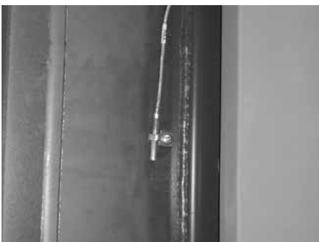
Obr. 15 - pohled na čidlo teploty spalin TSV na boku kouřového kanálu kotle DCxxSP(X), CxxSP, ACxxSP
