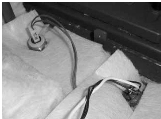
Obr. 16 - pohled na čidlo teploty vody TK v jímce kotle DxxGSP
