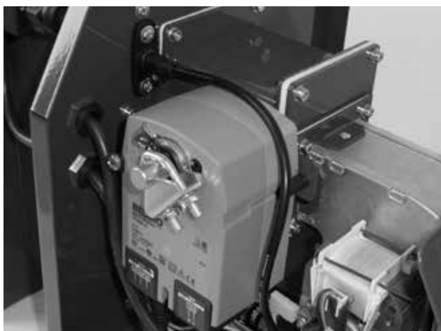
Obr. 11 - speciální klapka se servopohonem
