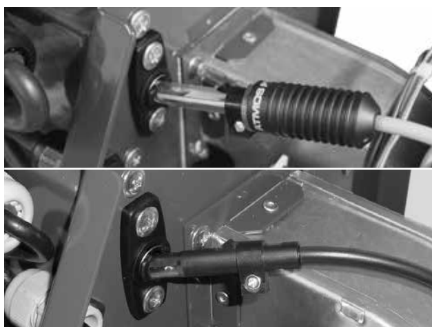
Rys. 4 - fotokomórka - należy uważać na prawidłowy kierunek podłączenia - zaleca się czyszczenie przynajmniej raz w roku nową fotokomórką / stara fotokomórka
