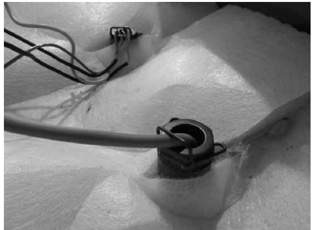
Abb. 16 - Ansicht des Wassertemperaturfühlers TK im Schutzrohr des Kessels Pxx, DxxP
