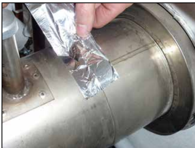
Abdichtung des Rauchabzugs mit Aluband
