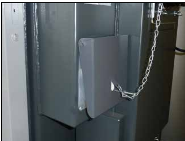
Geschlossene Klappe für die Zuführung von Verbrennungsluft am Kessel KCxxSP, DCxxSP(X), CxxSP - für die Modelle bis Baujahr 2018
