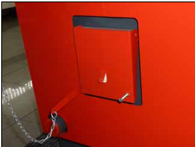
Geschlossene Klappe für die Zuführung von Verbrennungsluft am Kessel Pxx, DxxP
