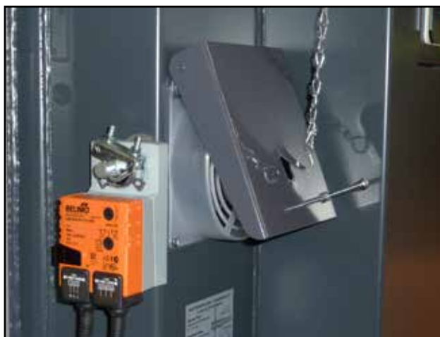
Die Luftzufuhr bei den Kesseln DCxxGSP ist automatisch durch Servoantrieb Belimo zugesperrt.
