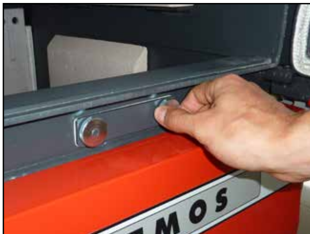
Nachgezogene Kappe der zusätzlichen Sekundärluft am Kessel Pxx, DxxP
