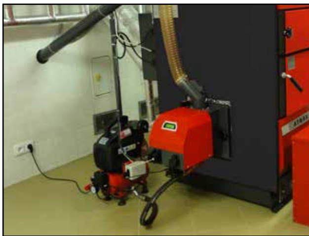
Anordnung des Verdichters neben dem Kessel
