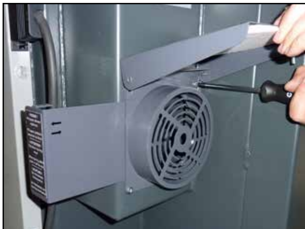
Montáž šoupátka pod klapku s mřížkou
