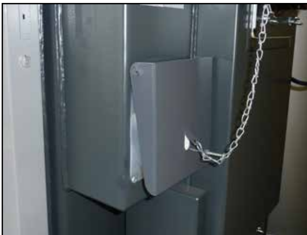
Uzavřená klapka pro přívod spalovacího vzduchu u kotle DCxxSP(X), CxxSP, KCxxSP
