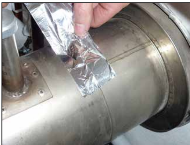
Utěsnění kouřovodu hliníkovou páskou
