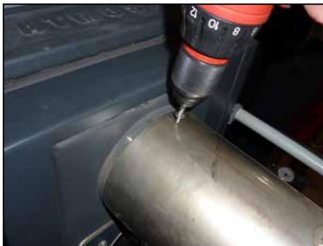
Ukázka zajištění kouřovodu šroubem
