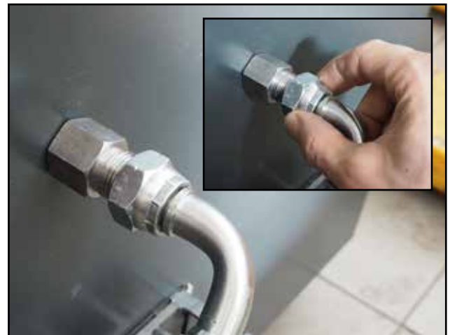
Schlauchanschluss (1/2“) hinten am Kessel
