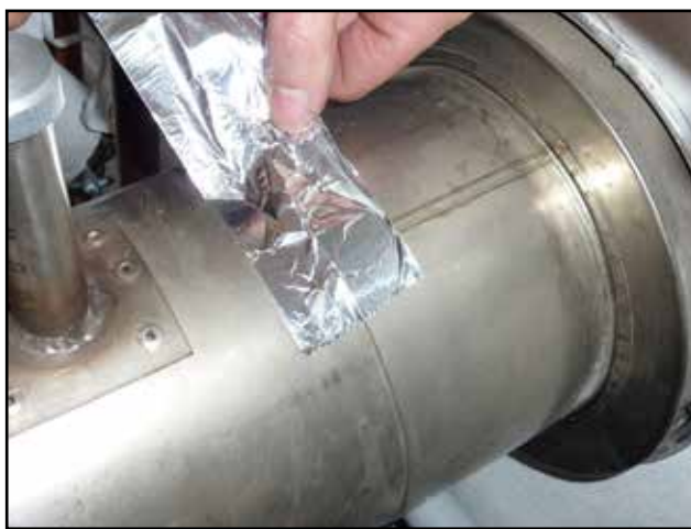
Abdichtung des Rauchabzugs mit Aluband
