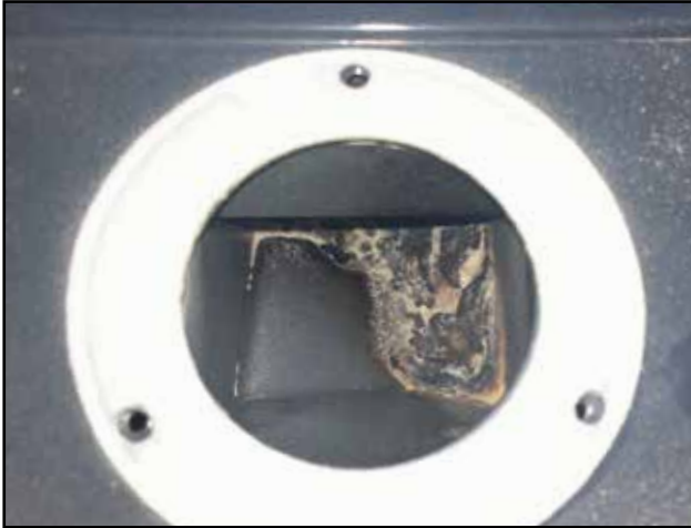
Zerkleinerte Pellets und hohe Staubmenge nach 3 Betriebsmonaten
