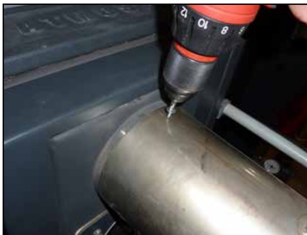
Beispiel der Befestigung des Rauchabzugs mit einer Schraube
