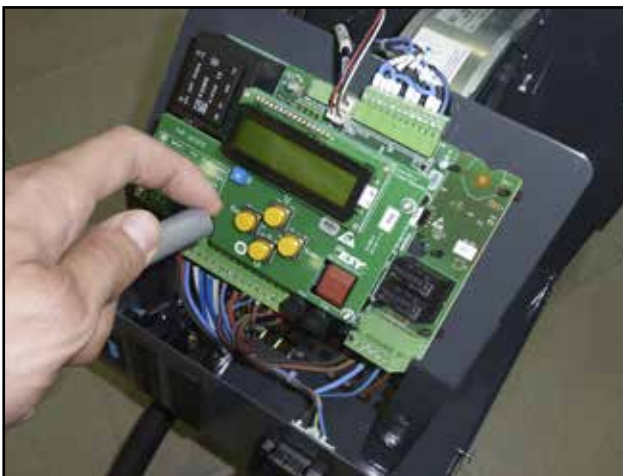
Reinigung (Ausblasen) des Brennerinnenraums (Stromlos schalten!).
