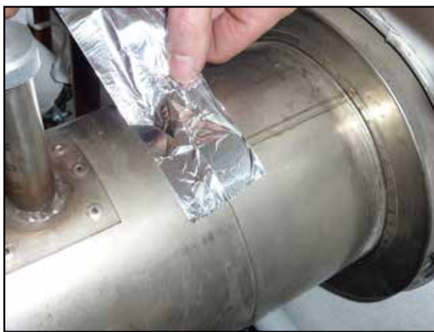
Abdichtung des Rauchabzugs mit Aluband
