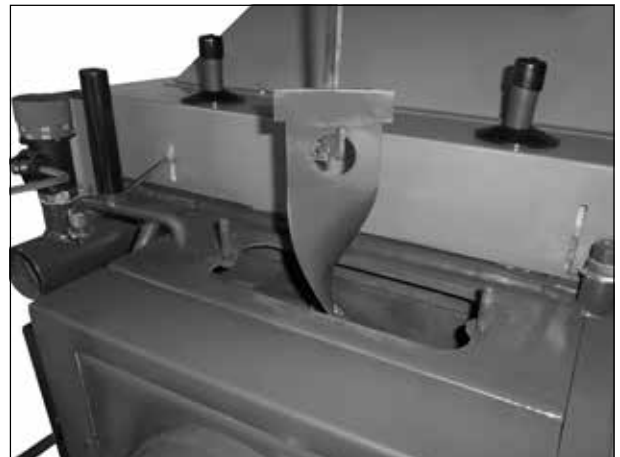
Ausziehen von Abgasbremser bei der Reinigung unter im hinteren Putzdeckel im hinterem Abgaskanal - KC35S
