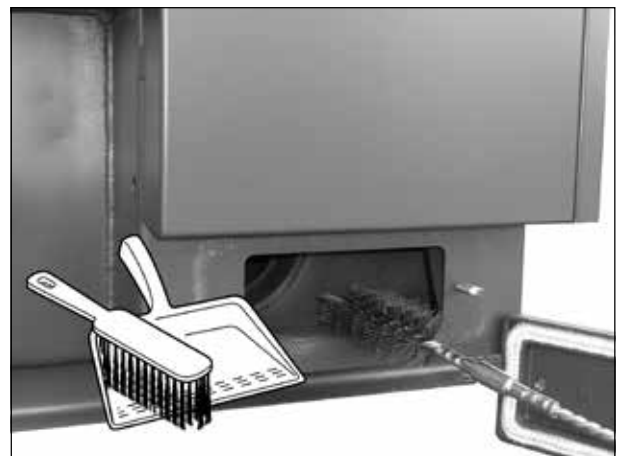
Vorführung der Reinigung des Rauchkanals mit Drahtbürste.
